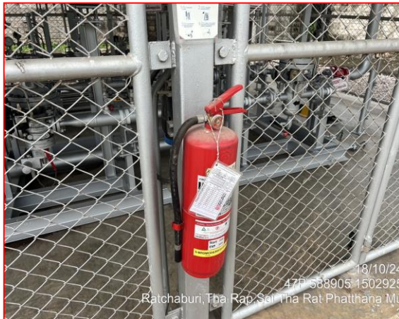
การติดตั้งถังดับเพลิงภายในสถานี
